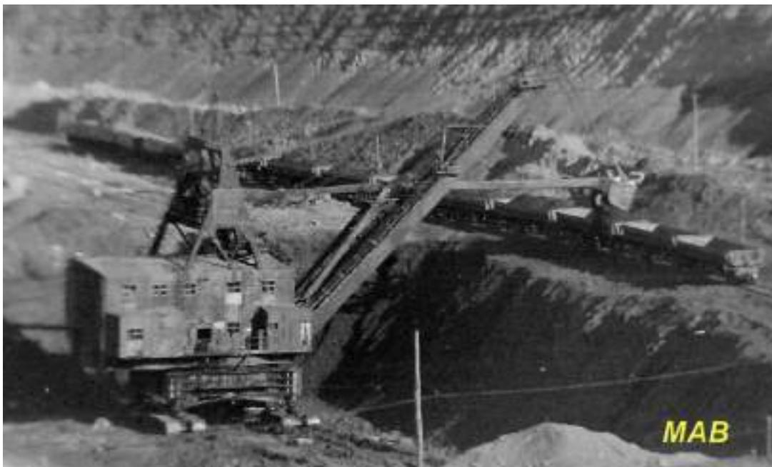
**Погрузка пород вскрыши в думпкары экскаватором ЭГЛ-15. Фото А.В. Могилкина**
