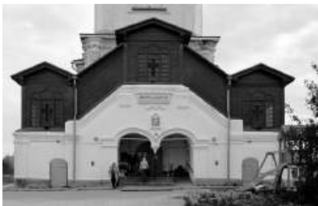
Крытая лестничная пристройка с двухмаршевым сходом на северную и южную сторону колокольни церкви Петра и Павла г. Североуральска.
