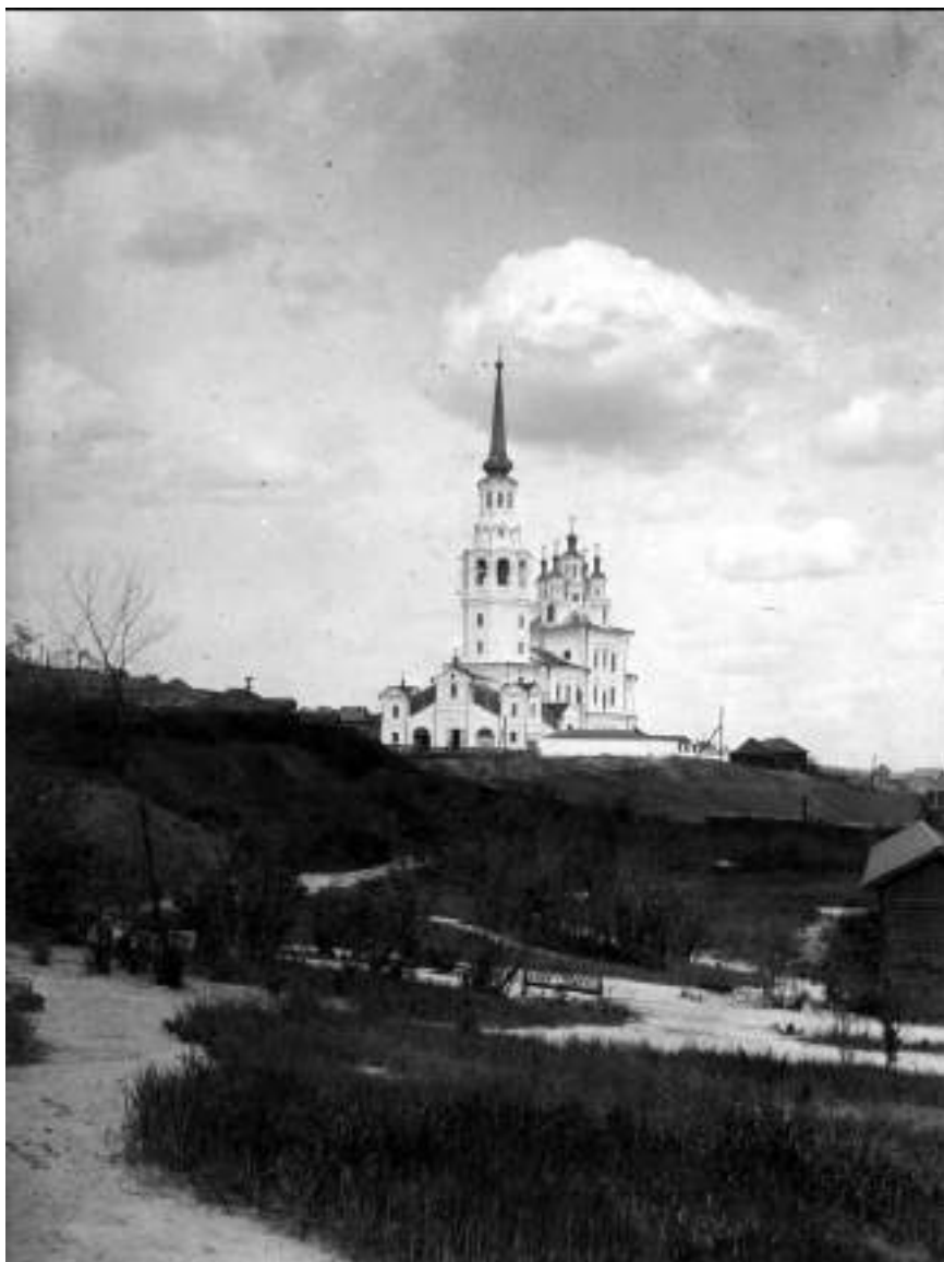
Введенская соборная церковь в Богословском заводе. Конец XIX – начало XX века.
